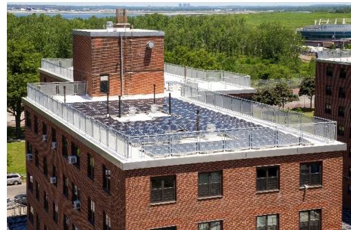
Techo reparado y sistema de paneles solares en Ocean Bay (Bayside)
