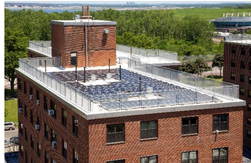
Ocean Bay (Bayside) 的屋頂和太陽能電池板系統維修
