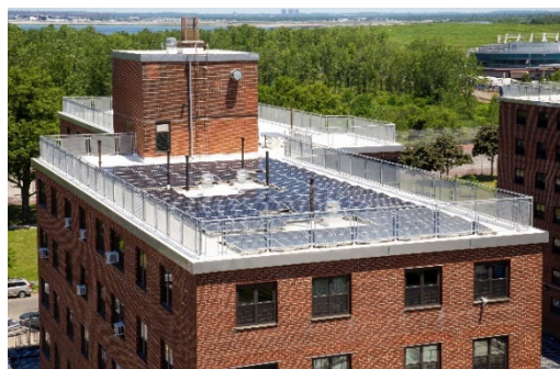
在Ocean Bay (Bayside) 的屋顶和太阳能电池板系统维修
