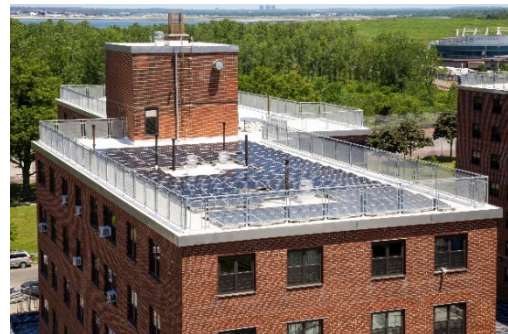
Отремонтирована крыша и система солнечных батарей в Ocean Bay (Bayside)
