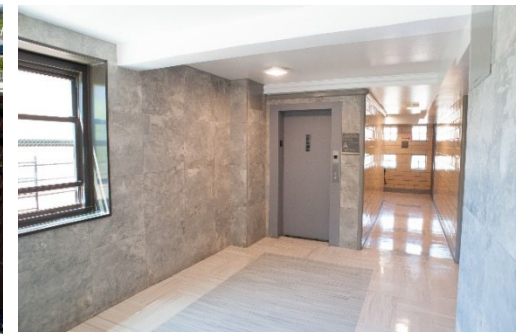
Отремонтированный вход в здание в Ocean Bay (Bayside)
