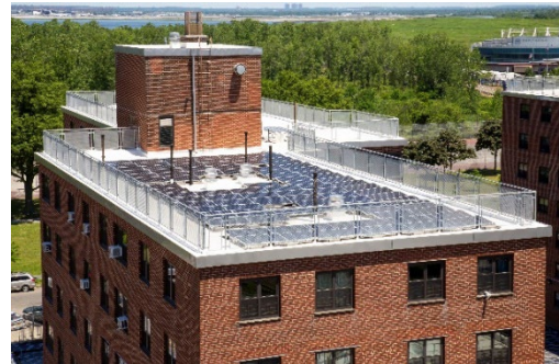
Отремонтирована крыша и система солнечных батарей в Ocean Bay (Bayside)
