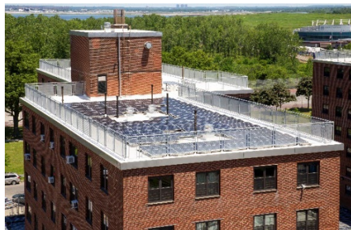
Ocean Bay (Bayside) 的屋顶和太阳能电池板系统维修
