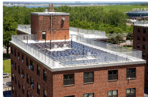
Ocean Bay (Bayside) 的屋頂和太陽能電池板系統維修
